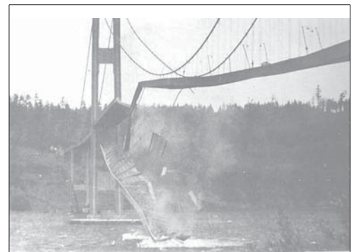
Pont de Tacoma Narrow après sa rupture
